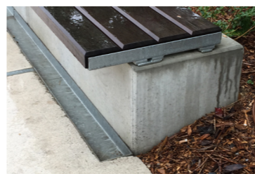
Exempel på infästning av sittyta.
