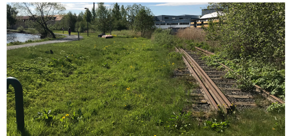
Västra delen med rester av tågräls.
